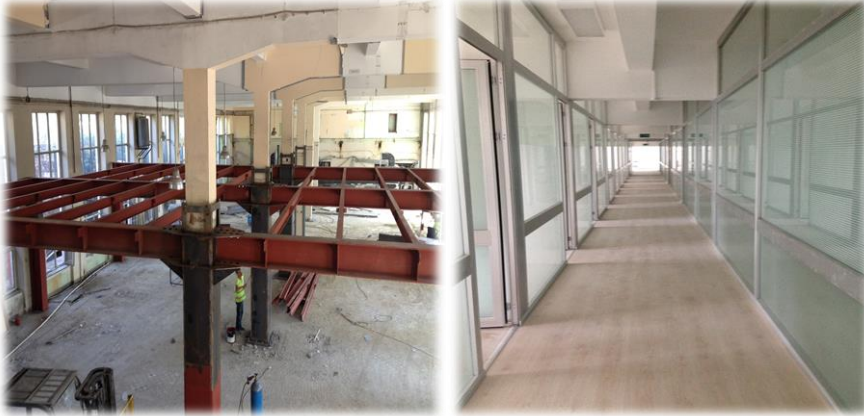
Yıldız Kamp.E Blok Asma Kat Onarım İşİ
